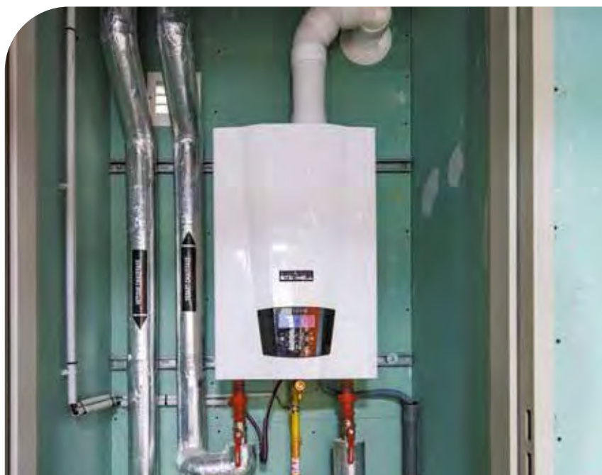
— Chaudière de 20 kW assurant le chauffage et l'ECS de huit logements.
