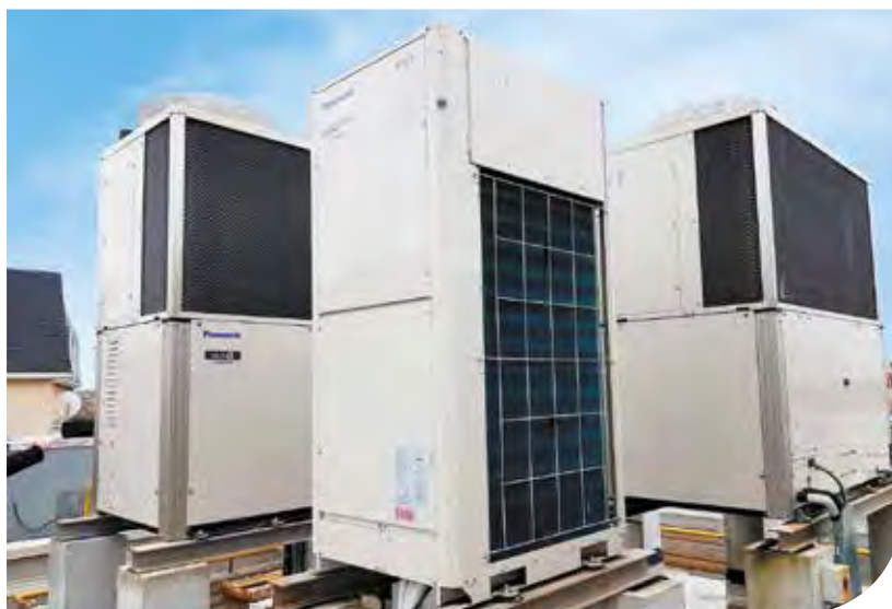
— Photo de la double PAC GHP + EHP installée sur le toit de la pharmacie de Roissy-en-Brie.
