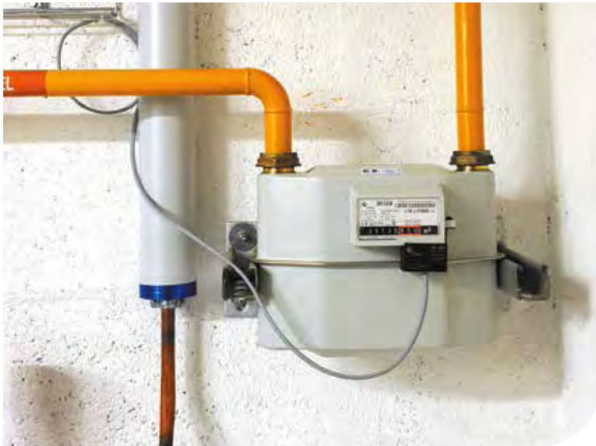
— Exemples de canalisations amont et aval compteur en acier
