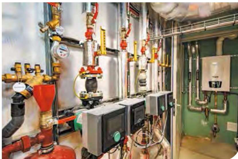
— L'une des six chaufferies compactes de la résidence (superficie 11 m 2 ).
