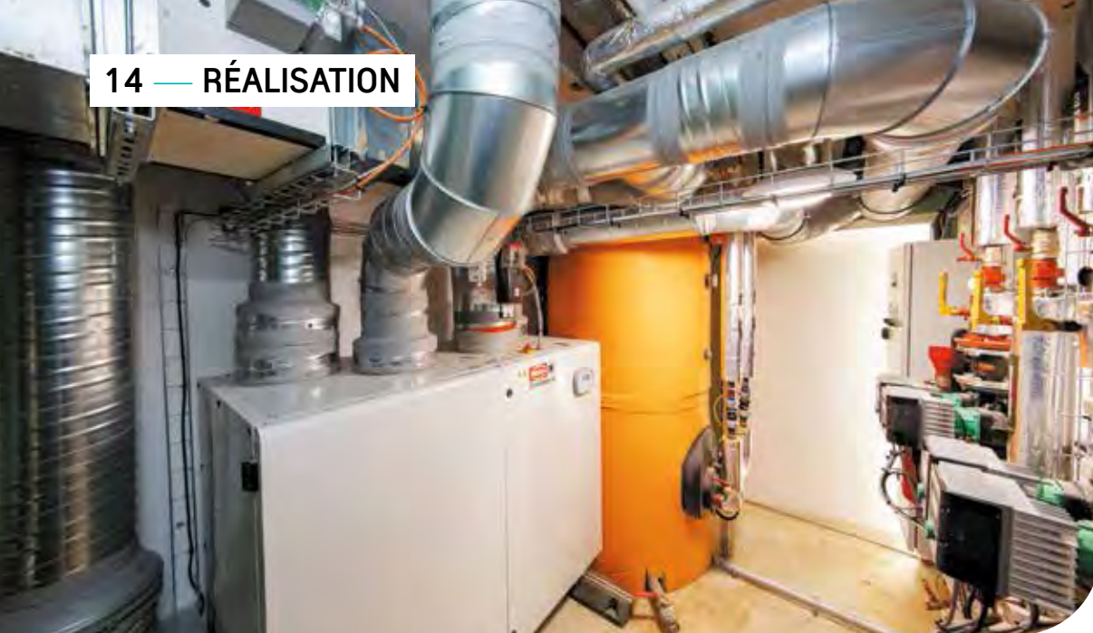
— Centrale double-flux dotée d'échangeurs à plaques (rendement de 88 %).
